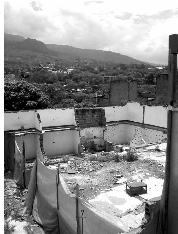
Puerto Nuevo, demolición para puente Madre Laura, 2014.
