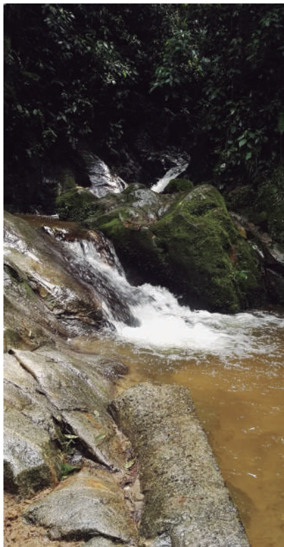
Bocatoma del barrio El Faro
