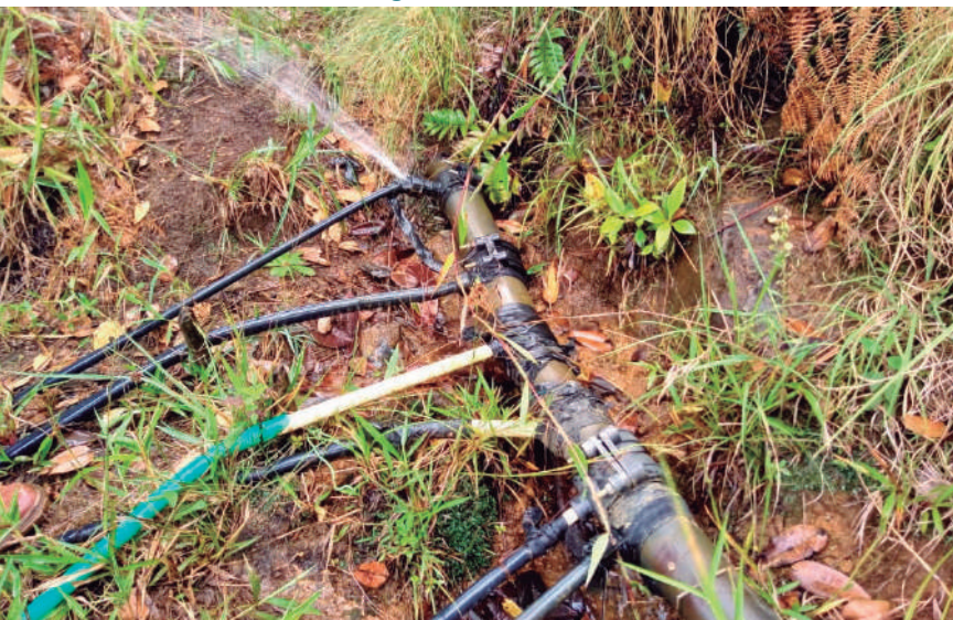
Cambio de manguera e instalación del sistema de flautas. Convites del barrio Bello Oriente
