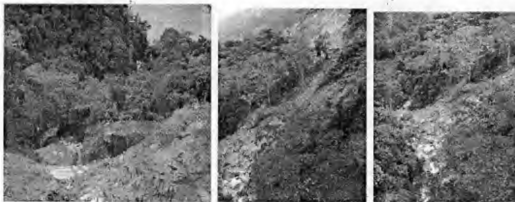
Fotografías 26 a 28: Verificación en terreno CGR 14 y 16 de abril/2018 sector vía Puerto Valdivia a Presa.
