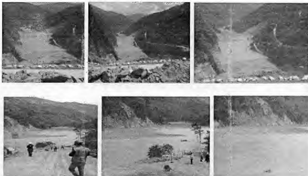
Fotografías 17 a 22: Verificación en terreno CGR 13 de abril/2018 sector de presa, cara húmeda.
