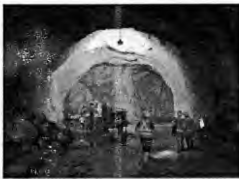
Fotografía 3.100 Perforación frente del ramal derecho
