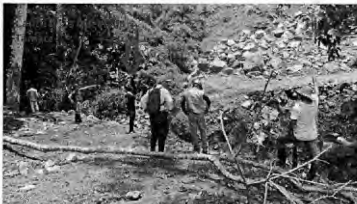
Fuente: Registro fotográfico CGR del día 17 de abril de 2018, entrada al depósito Km 9+500.
