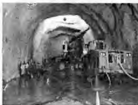
Fotografía 3.91 Instalación pernos BRL 8 en la caverna cámara de compuertas
