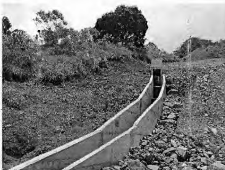
Fuente: Registro fotográfico CGR del día 17 de abril de 2018, desvió fuente hídrica en la parte alta del depósito Km 9+500, se observa canal perimetral número 2 totalmente aislado del depósito.
