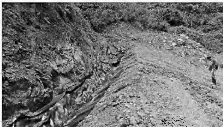
Fuente: Registro fotográfico CGR del día 17 de abril de 2018, desvió fuente hídrica en la parte alta del depósito Km 9+500.
