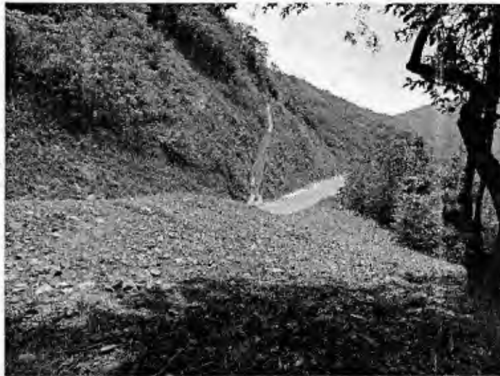
Fuente: Registro fotográfico CGR del día 17 de abril de 2018, talud de la vía puerto Valdivia presa utilizada como depósito.
